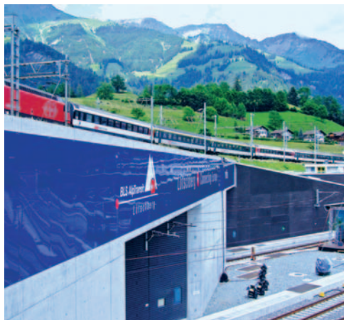
2007: Nordportal des Lötschberg-Basistunnels
