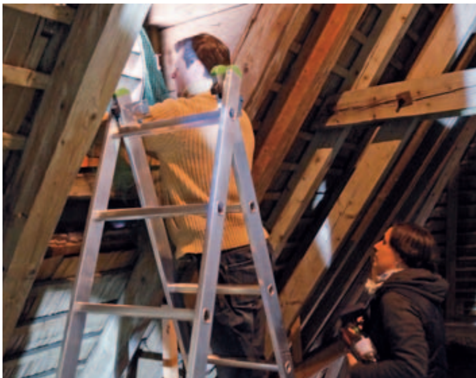
Zwei Mitarbeitende befestigen ein Gitter am Dachfenster der Kirche.
