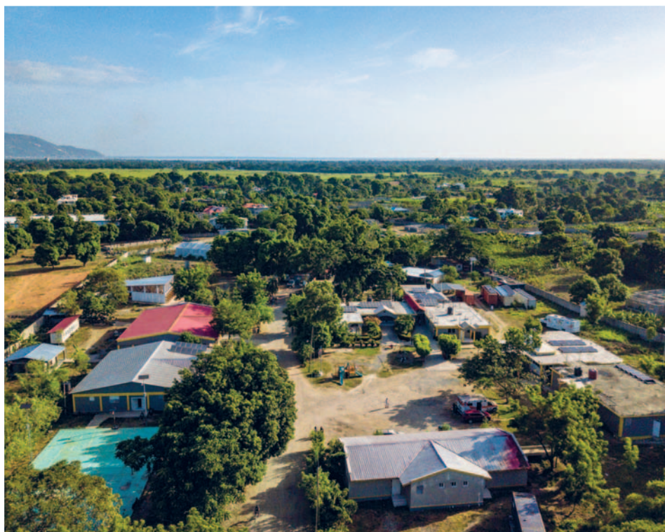
Bereits einige Dächer des Hôpital Convention Baptiste d'Haiti in Cap Haitien sind mit einer Fotovoltaikanlage bestückt.
