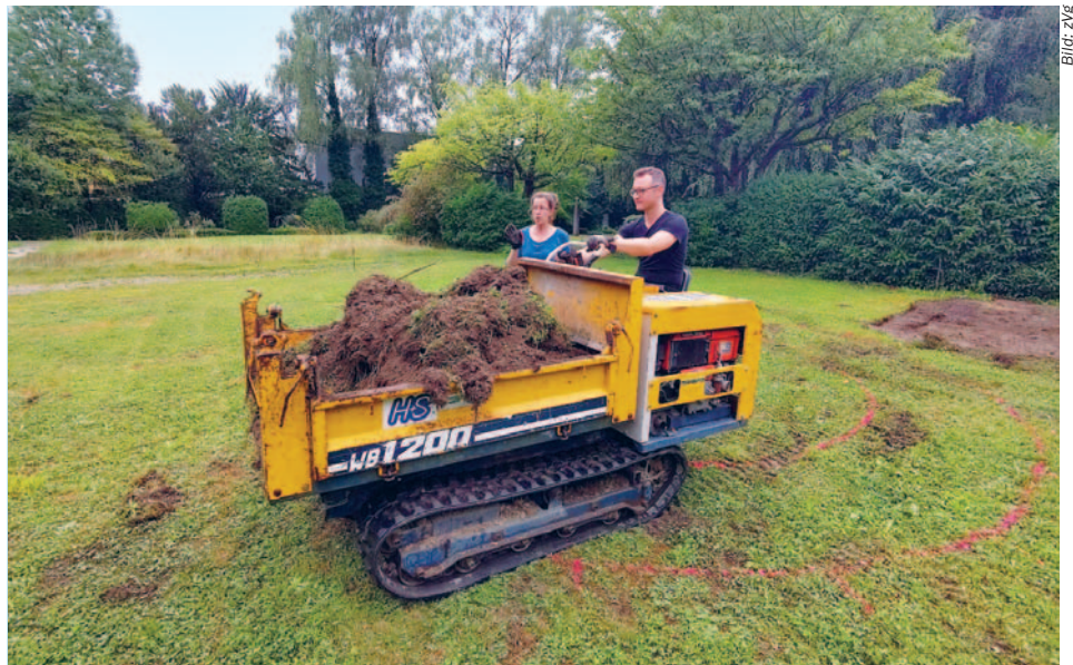
Monika Visintin und Marco Bertschinger bei Erdarbeiten für den Bibelgarten im Sommer 2022
